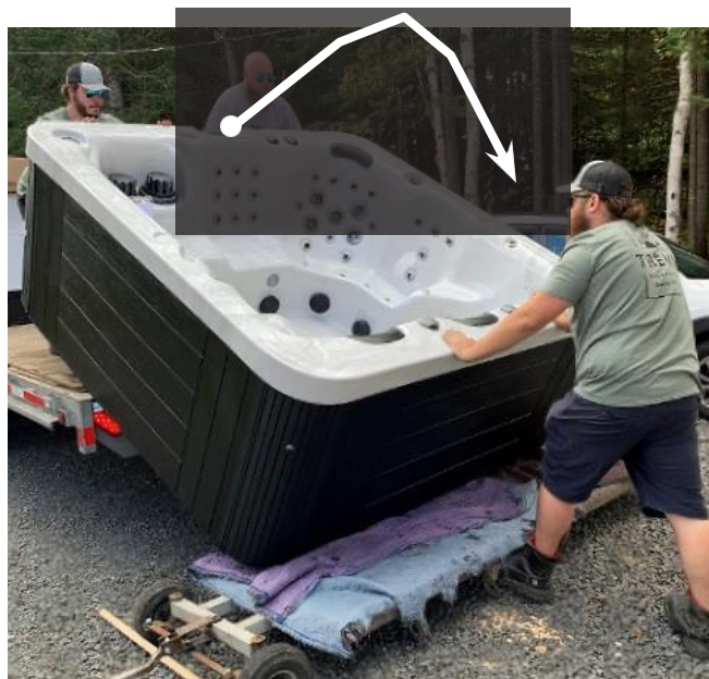
Descendre le spa du camion de livraison pour le mettre à la verticale sur le chariot sur roues
