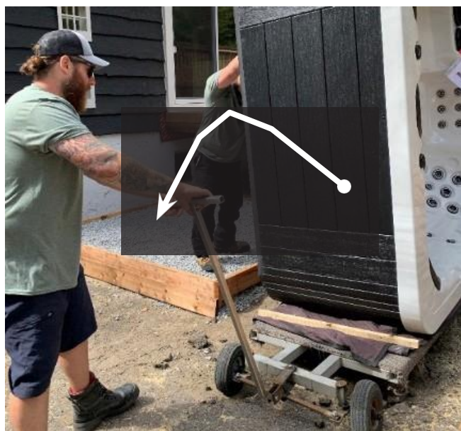
Installer le spa sur une base en pierre concassée 0-3/4
