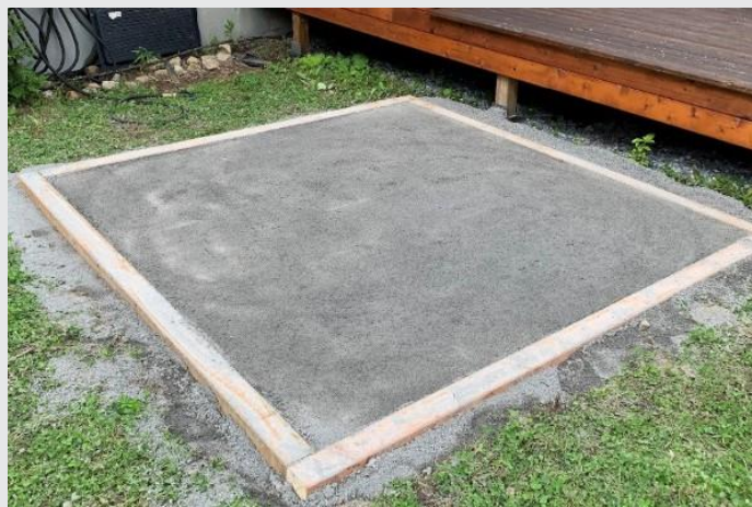
Exemple d'installation sur poussière de roche
