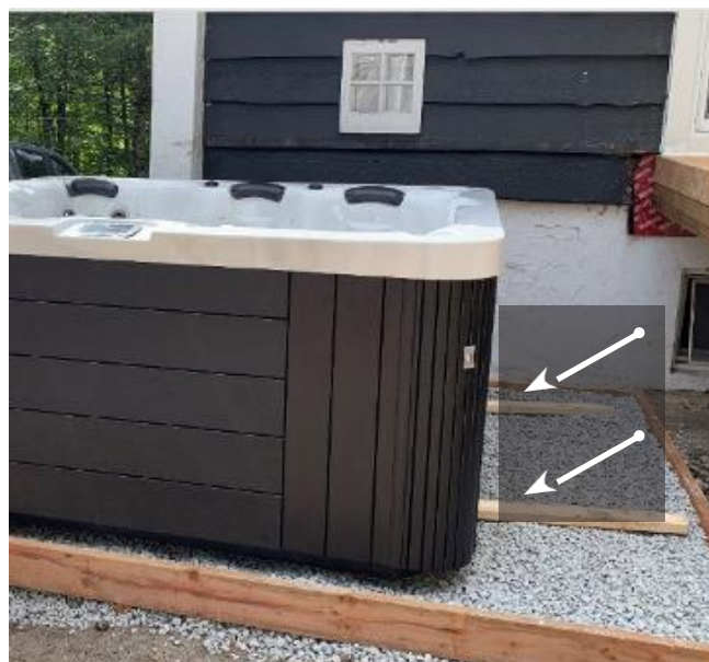
Pour le mettre en place, le spa est parfois déposé sur deux 2x4 afin d'éviter de déniveler la base en poussière de roche et d'abîmer le spa
