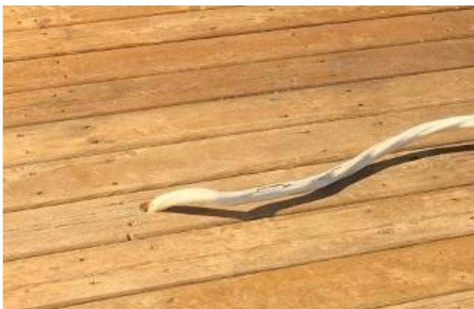
Exemple de branchement (fil) électrique dont le fil passe sous le spa sans tuyau en PVC.
